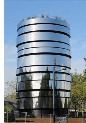
La tour permet de stocker 1000 m<sup>3</sup> d'eau. La nuit, la tour récupère l'énergie issue de l'usine de valorisation énergétique des déchets située à proximité, ce qui permet de porter la température de l'eau à 98°C. Au matin, on utilise une partie de l'énergie stockée pour chauffer des locaux de l'université.
